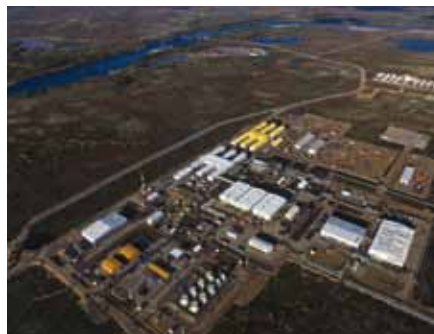
Блокированные здания с применением систем температурной стабилизации «ГЕТ» и «ВЕТ» на Ванкорском месторождении
