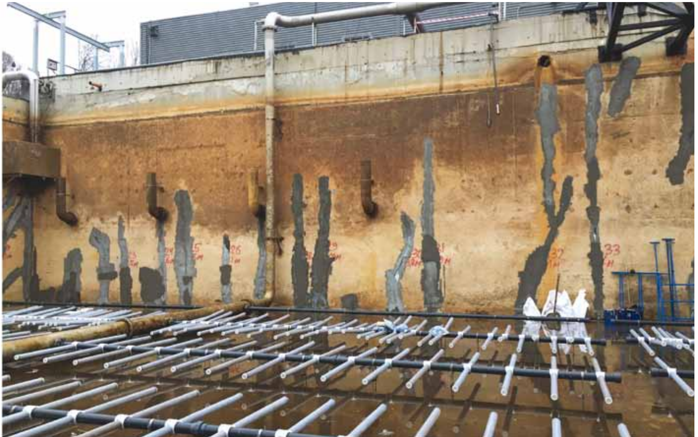
Герметизация железобетонного аэротанка на «Московской Пивоваренной Компании»
