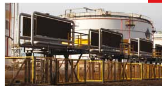
Системы температурной стабилизации грунтов «ГЕТ» в основании резервуаров. Ванкорское НГКМ
