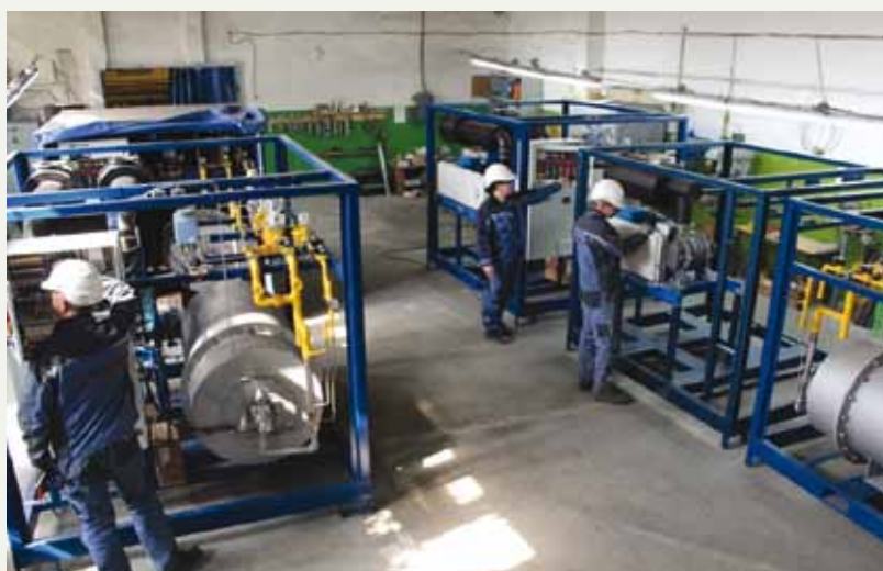
Сборка парогенераторов ИнтерБлок в производственном цехе
