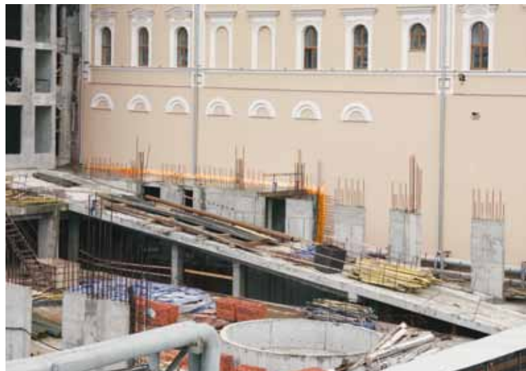
Гостиничный комплекс «Царев сад» на Софийской набережной, г. Москва. Применение системы деформационных швов между строящимся и существующим зданием.
