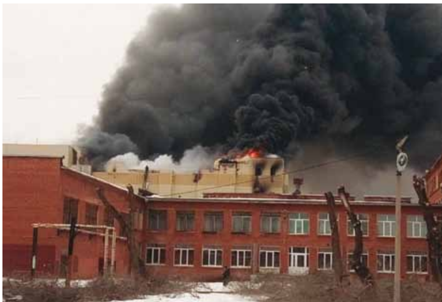
Горение кровли в ТРЦ "Зимняя Вишня"
