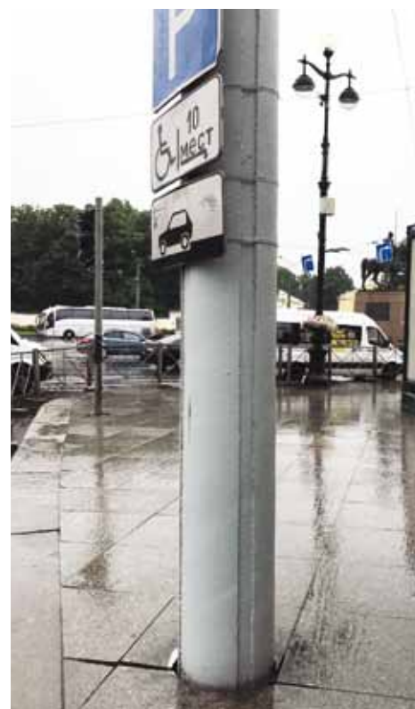
Окраска опоры контактной сети материалом «антиграффити» Санкт-Петербург
