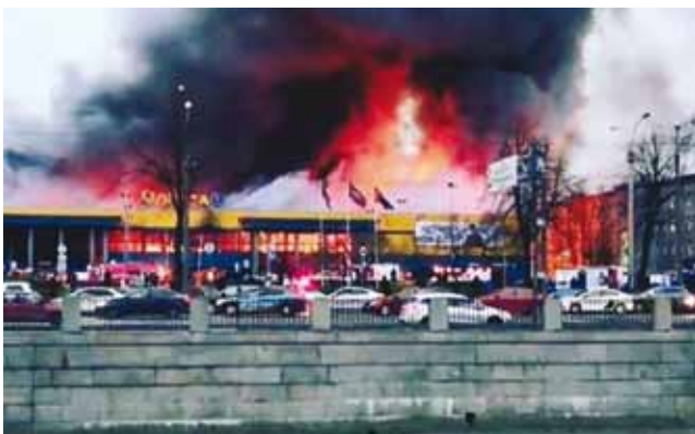
Пожар в ТЦ "Лента" г. Санкт Петербург 10.11.2018г.
