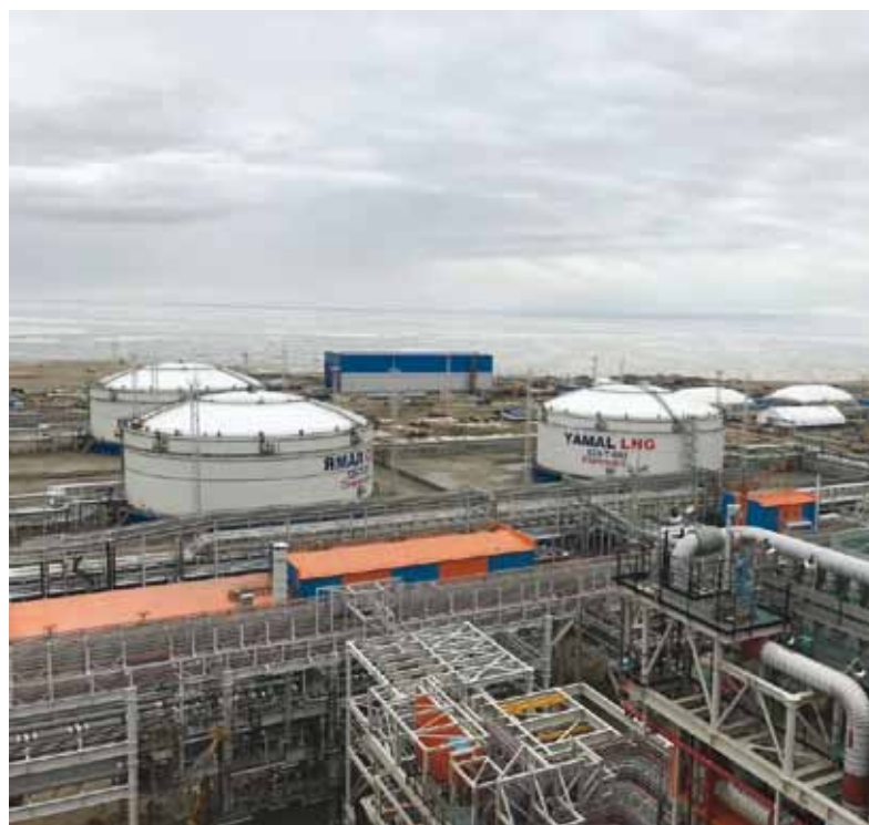
Завод Ямал СПГ
