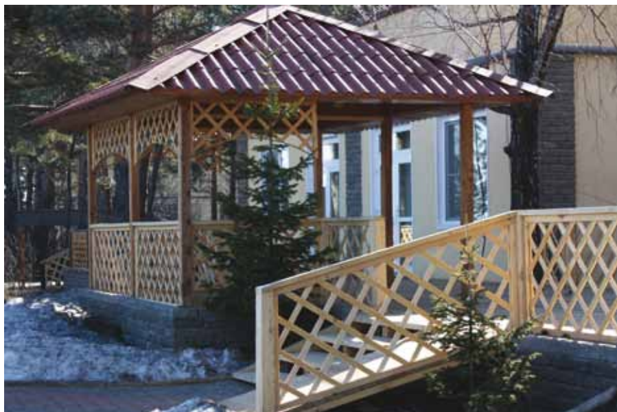
Обустройство беседки хризотилцементными волнистыми цветными листами
