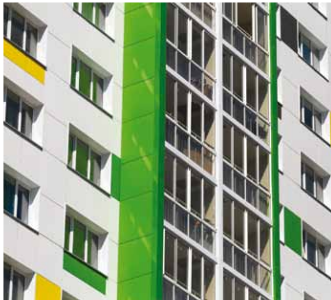
Окрашенные хризотилцементные фасадные плиты в облицовке здания
