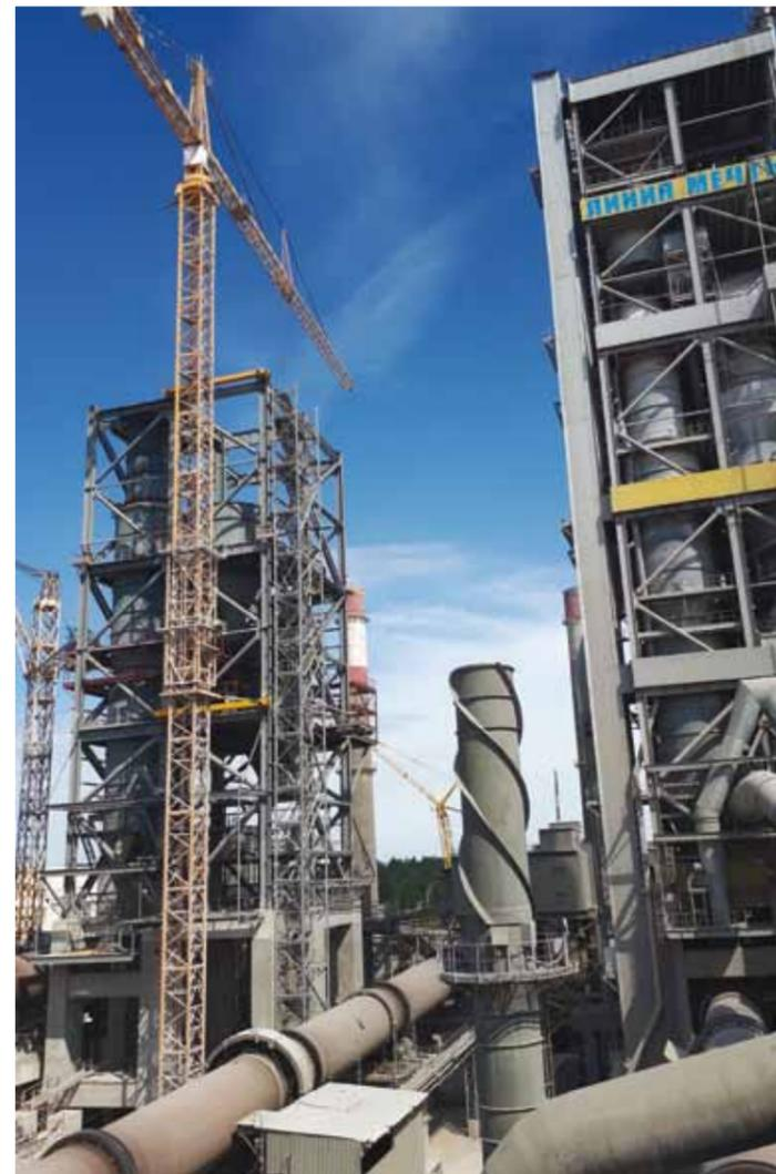
заказчик, изготовление которого размещено на отечественных и зарубежных заводах. Монтаж готового оборудования из-за большого веса и габаритов совмещается с монтажом металлоконструкций зданий и сооружений в соответствии с графиком. В высокотемпературных зонах технологического процесса предстоит уложить более 2600 тонн огнеупорных изделий.
