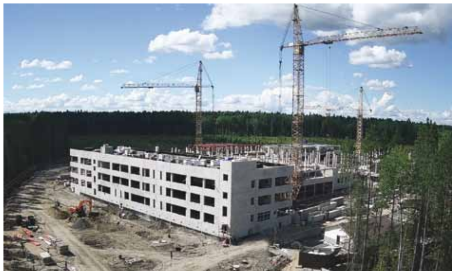
Строительство школы на 1350 мест, г. Петрозаводск
