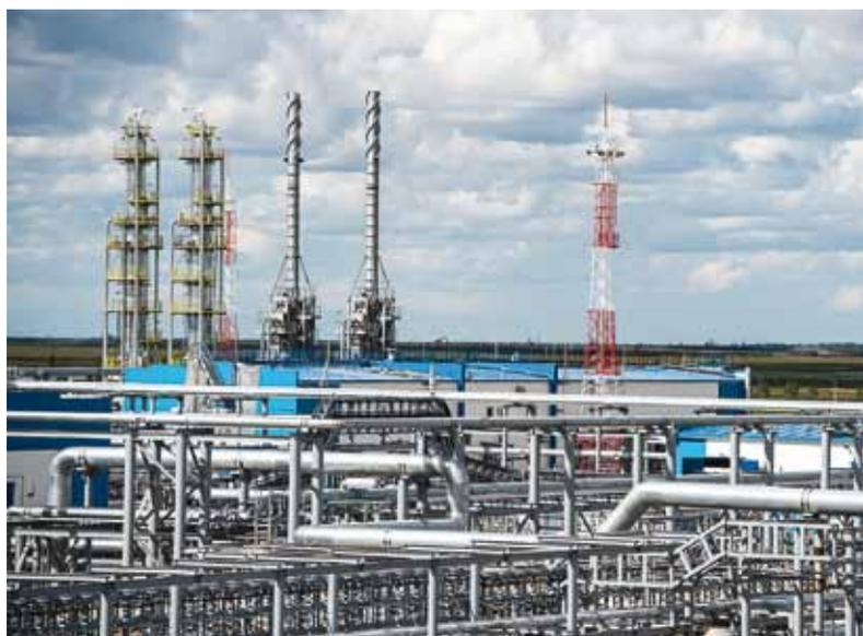
В августе 2020 закончено строительство малотоннажного завода по производству СПГ в Магнитогорске мощностью 40 тыс. тонн в год. Продукцией завода является сжиженный природный газ (СПГ) и очищенный природный газ для промышленного/бытового применения «газ обратного потока».
