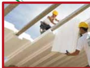
Пенополистирол, благодаря своим свойствам, обеспечивает необходимые теплотехнические характеристики строящихся или реконструируемых объектов. Пенополистирол применяется при утеплении фасадов, кровель, перекрытий, фундаментов, цоколей, перегородок, лоджий.
