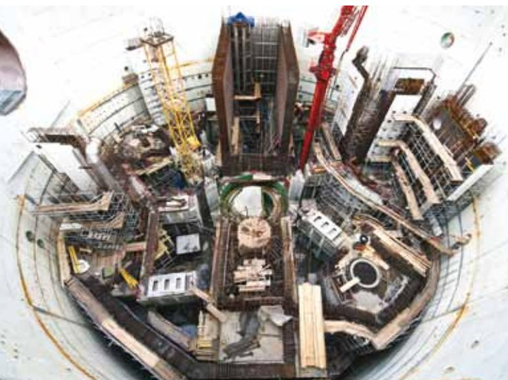
тяжелое оборудование, монтируют армоблок перекрытия и бетонируют его. Применение данной технологии должно способствовать не только повышению эксплуатационных качеств объекта, но и скорости выполнения строительно-монтажных работ при возведении блоков АЭС минимум в 1,5 – 2 раза быстрее.
