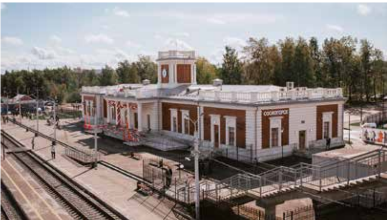
Реконструкция вокзала Сосногорск
