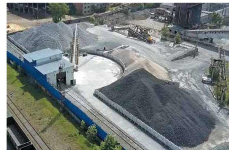
Новый комплекс складирования сырья
