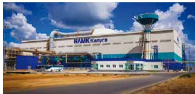
Комплекс работ на объектах ПАО «НЛМК»
