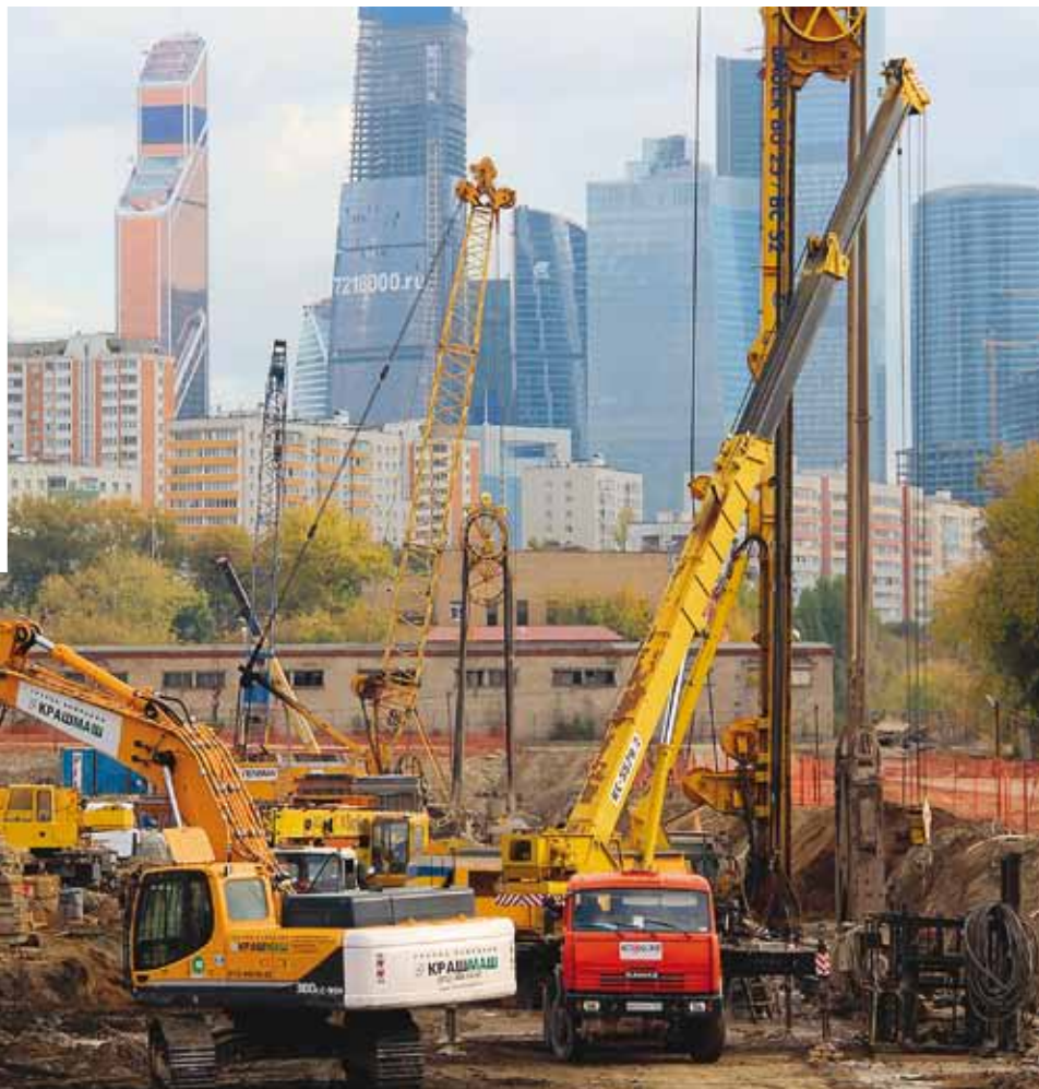
г. Москва. Разработка котлована в промзоне ФИЛИ и его ограждение методом «стена в грунте»
