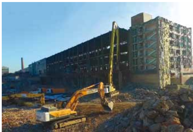
г. Москва. Демонтаж Московского металлургического завода «Серп и Молот»
