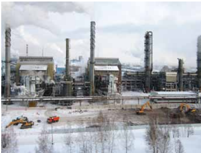
г. Томск. Демонтаж более 50 зданий на действующем нефтехимическом предприятии «ТомскНефтехим»
