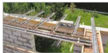
Рис. 5 Устройство балкона в составе перекрытия МАРКО-ПРОФИЛЬ
