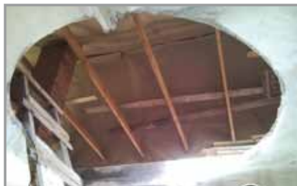
Рис. 11. Круглый проем в перекрытии
