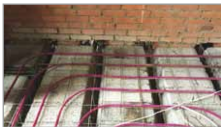
Рис. 9. Прокладке водяного теплого пола в перекрытиях МАРКО
