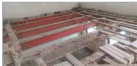
Рис. 2 Стыковка балок сталебетонных перекрытий при реконструкции объекта
