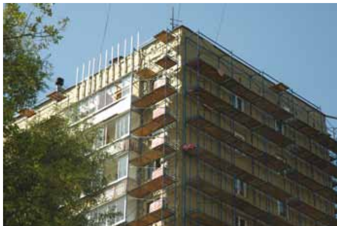
Утепление здания по программе капитального ремонта
