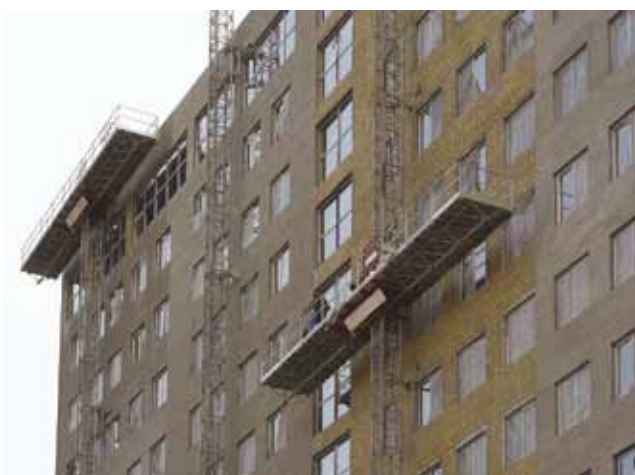
Строительство энергоэффективного здания в Санкт-Петербурге
