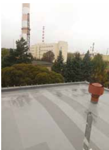
Кровля здания Физико-энергетического института г. Обнинск
