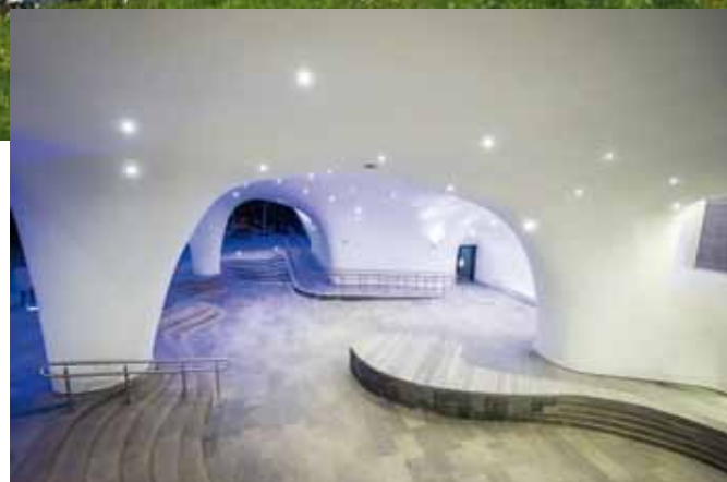
Фасады "Ледяной пещеры" в парке "Зарядье" выполнены из стеклофибробетона методом 3D-принтинга
