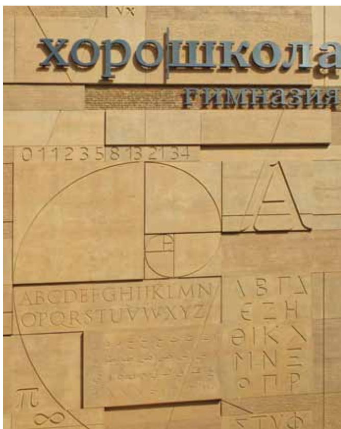
Фасады Хорошевской гимназии выполнены из фибробетонных панелей с имитацией фактуры травертина и дерева
