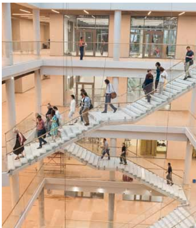
Лестница выполнена из сверхпрочного бетона, эквивалентного по прочности стали
