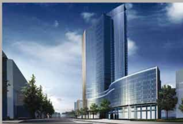
Альтра Седе, Милан, Италия Заказчик: Регион Ломбардия Толщина плиты: 35 см Снижение нагрузок: 61,000 кН Снижение выбросов CO 2 : 512 тонн
