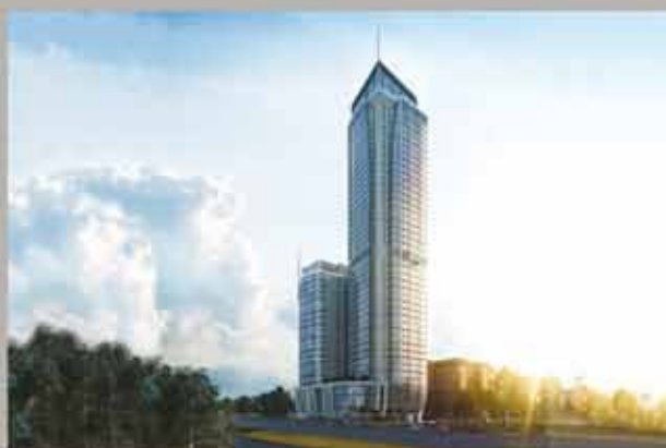
Ingria Tower, Санкт-Петербург Заказчик: ГК "С.З.Р." Толщина плиты: 25 см Снижение нагрузок: 53,900 кН Снижение выбросов CO 2 : 172 тонны
