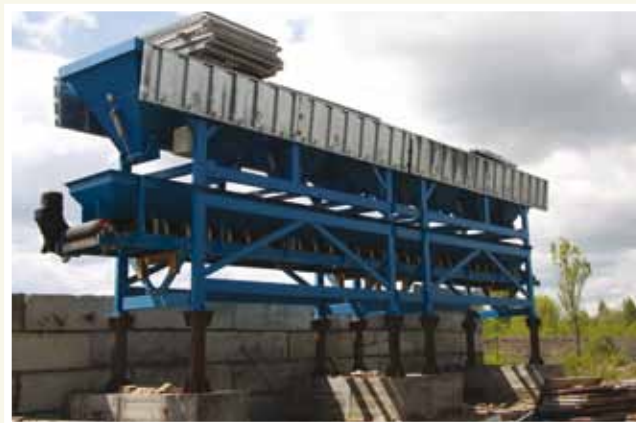
Строительство бетонного узла в г. Карачев
