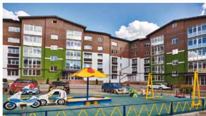
Жилой комплекс "Мегаполис-Парк"
