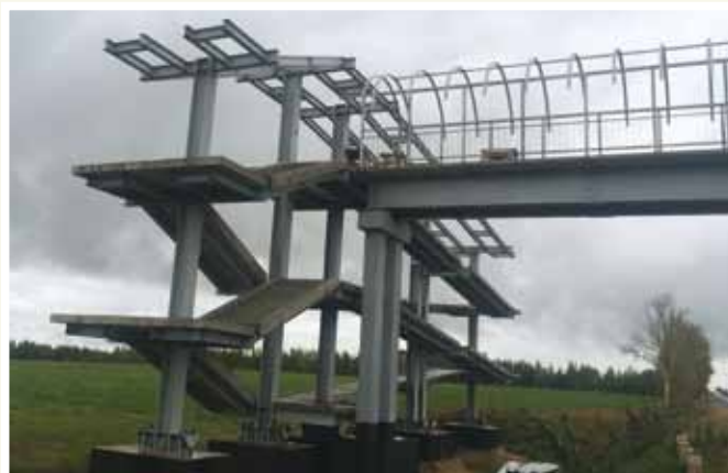
Элементы мостовых конструкций, установленных на трассе М3
