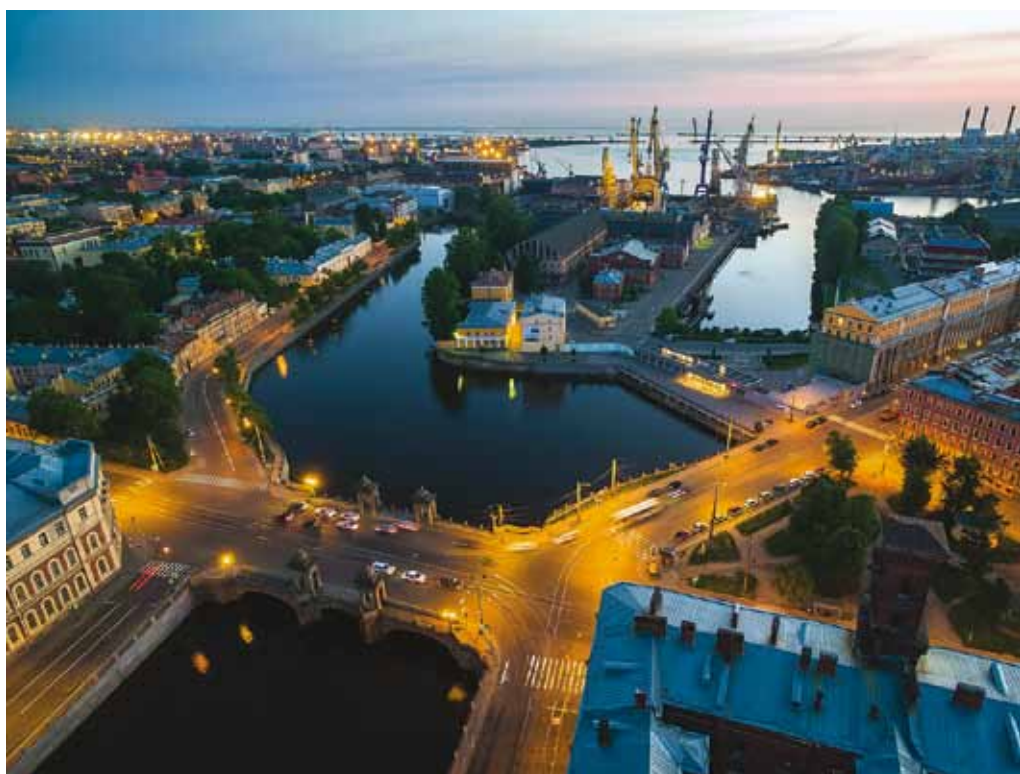
АО «Адмиралтейские верфи» Реконструкция участка 1 цеха № 7 АО Адмиралтейские верфи.
