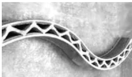
Рис. 2. Вид сверху на фрагмент стены изогнутой формы. Хорошо видны диагональные перегородки и пустоты между ними для заливки пенобетона
