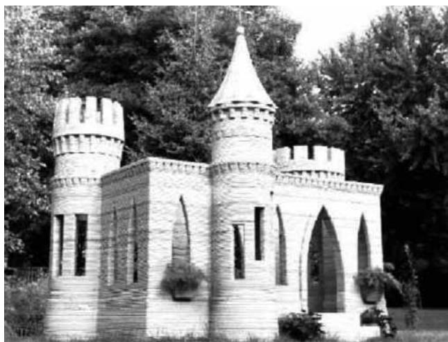
Рис. 3. Уменьшенная модель замка из бетона, построенная строительным 3D-принтером. Высота модели до верха центральной башни 4,5 метра
