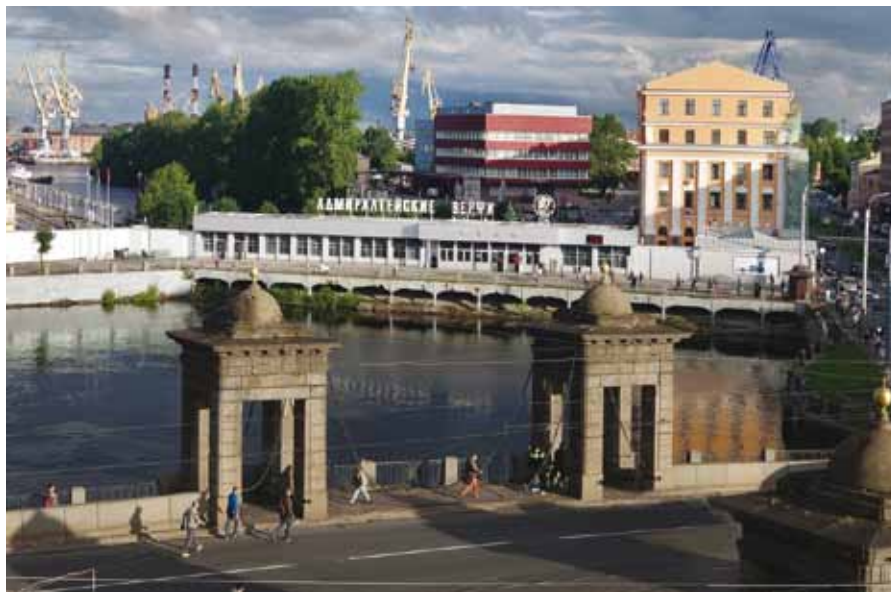
АО «Адмиралтейские верфи» Реконструкция участка 1 цеха № 7 АО Адмиралтейские верфи.
