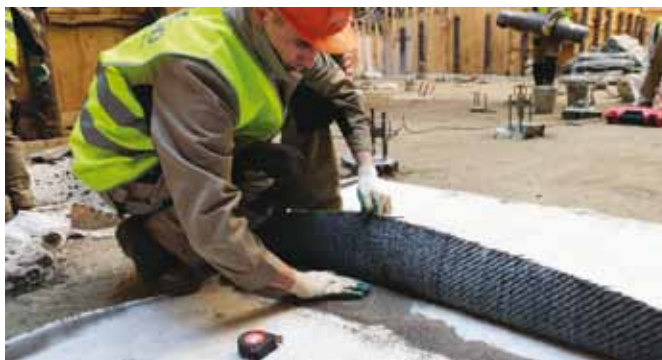
Рис. 3. Реставрация фундамента здания г. Москва
