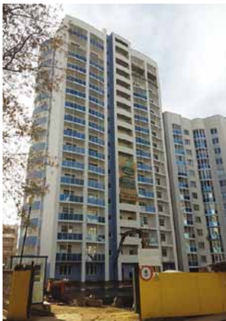
Жилой комплекс «Берёзки»
