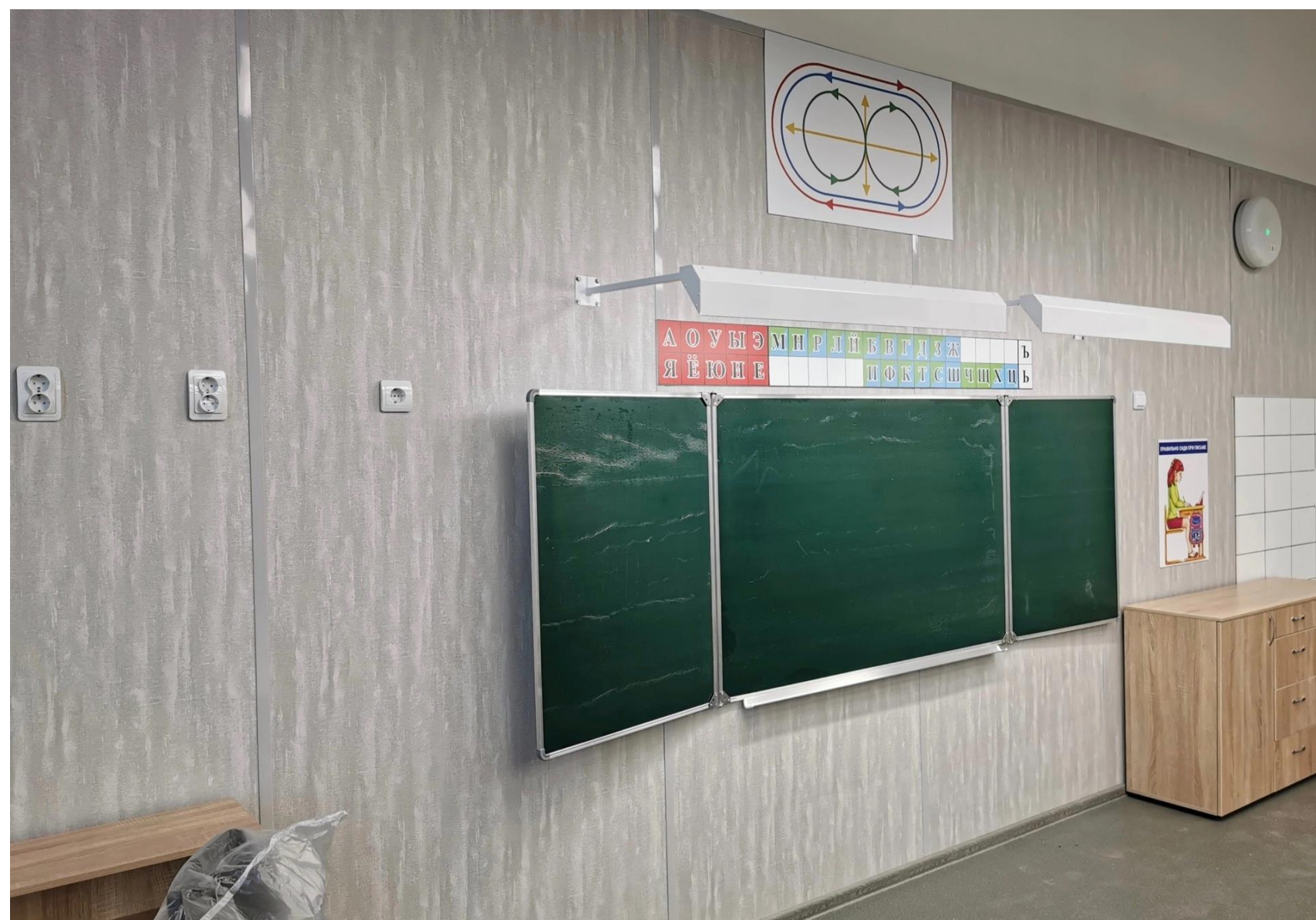
Начальная школа г. Белгород. Стеновые панели на основе ГСП в пленке ПВХ
