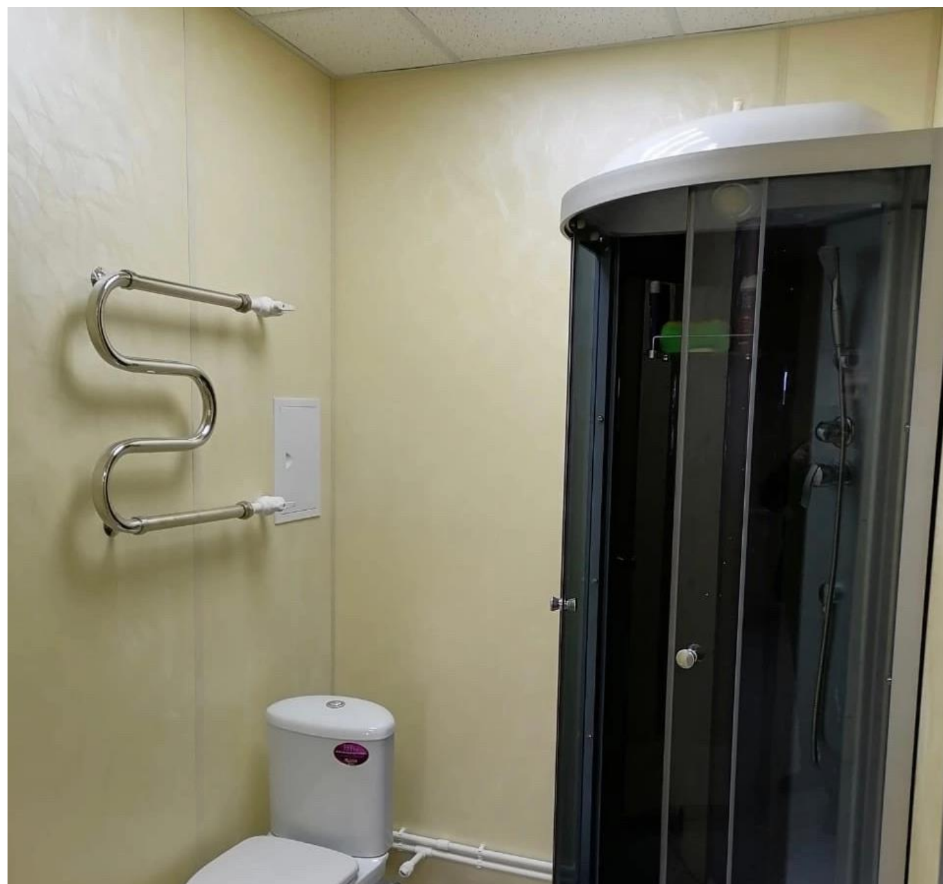
Санузел в гостинице г.Рязань. Стеновые панели на основе ГСП в пленке ПВХ
