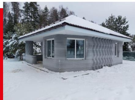
Полевые строительные принтеры (в линейке АМТ это принтеры серии 300 и 500), предназначены для печати зданий на фундаменте.
